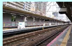
④整備された新型ホームドア
