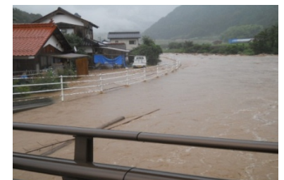
山口県萩市浸水状況
