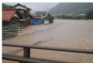
山口県萩市浸水状況
