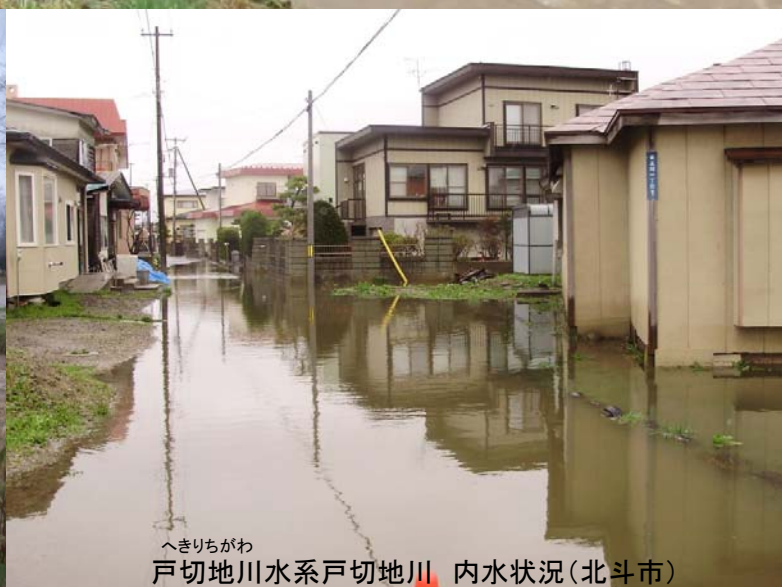
折戸川水系軍川 堤防越水状況(亀田郡七飯町)
