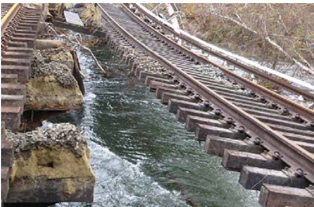
洗掘され線路が流出©MTA
