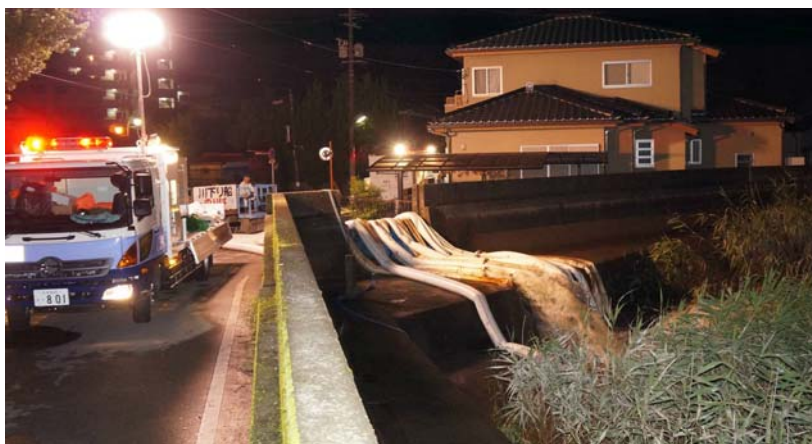
排水ポンプ車による排水作業 (福岡県柳川市)
