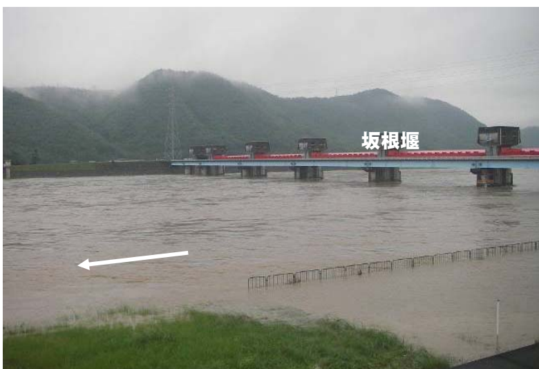
吉井川水系吉井川の出水状況(備前市坂根地先)
