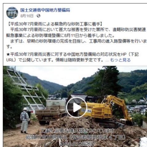
緊急的な砂防工事着手(整備局Face bookより)
