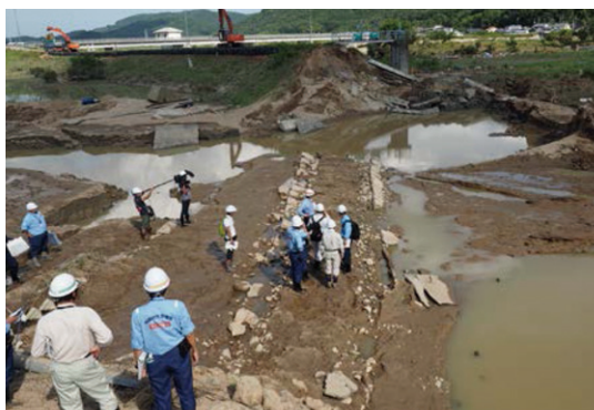
堤防調査委員による現地調査（小田川）
