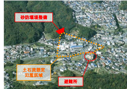
砂防堰堤整備が必要な箇所
