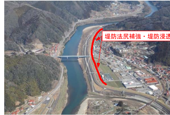
堤防強化が必要な箇所
