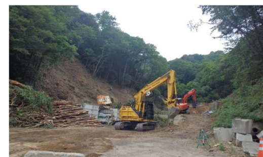
樹木伐採 施工状況
