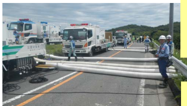
自衛隊・警察・消防、工事用車両の通行車線
