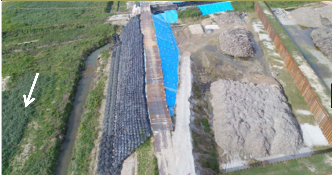
平成30年10月30日 本復旧工事に着手
