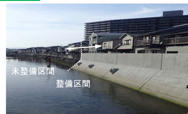
海岸堤防の整備
