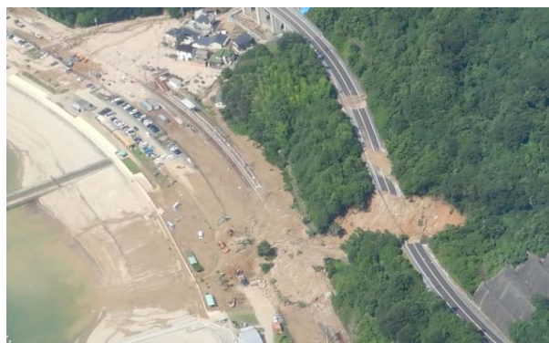
写真:平成30年7月豪雨 E31広島呉道路(暫定2車線)被災状況 高速道路の4車線化
