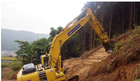
本体掘削 施工状況
