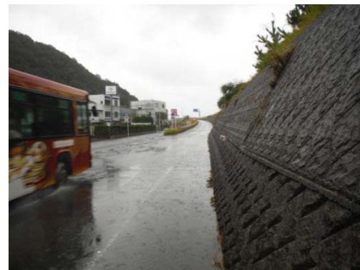
道路の冠水状況
