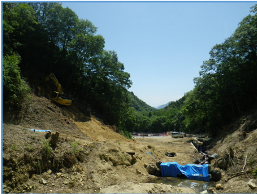
砂防堰堤の本体掘削状況①
