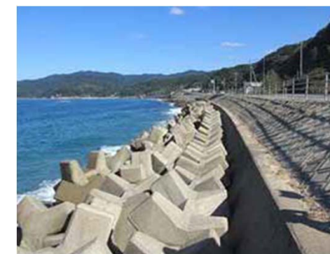
対策事例(消波ブロック設置)
