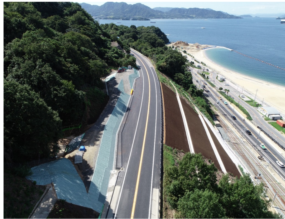
広島呉道路、国道31号復旧状況(広島県安芸郡坂町)
