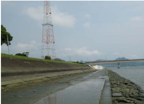
高潮対策が必要な箇所
