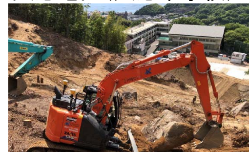
本体掘削 施工状況
