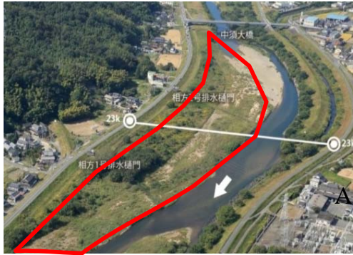
河道掘削・樹木伐採が必要な箇所
