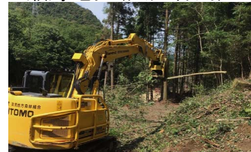
樹木伐採 施工状況
