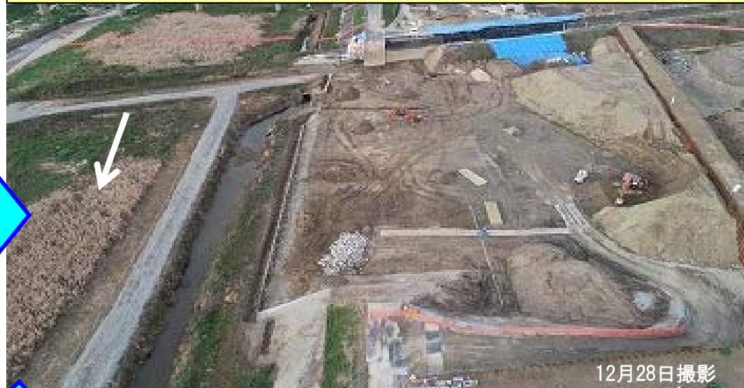
荒締切堤防（仮設堤防）の撤去作業中
