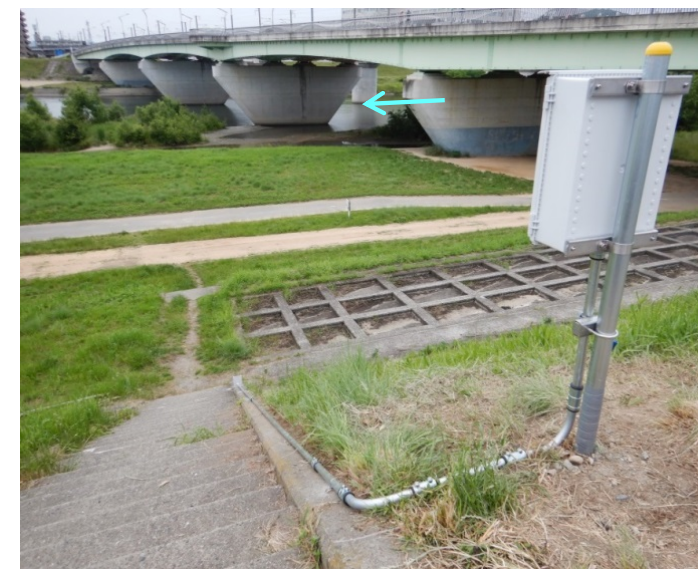
危機管理型水位計設置状況
