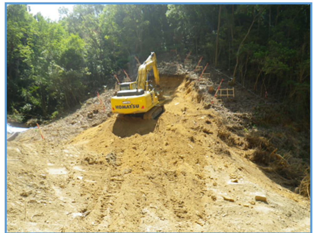
砂防堰堤の本体掘削状況②
