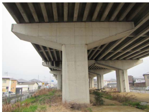
補強が必要な橋脚
