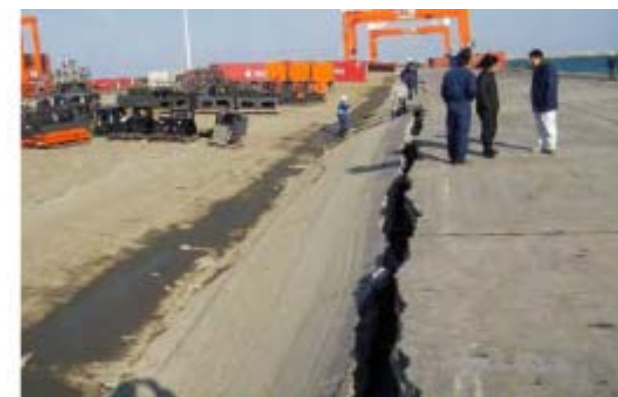
写真:非耐震強化岸壁背後の陥没
