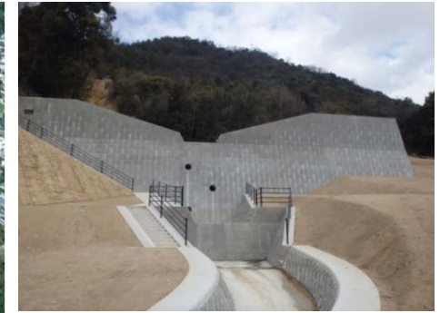
対策事例(砂防堰堤)
