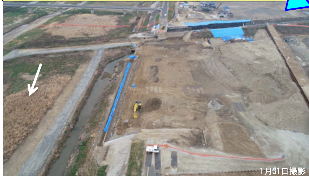
荒締切堤防（仮設堤防）の撤去完了
