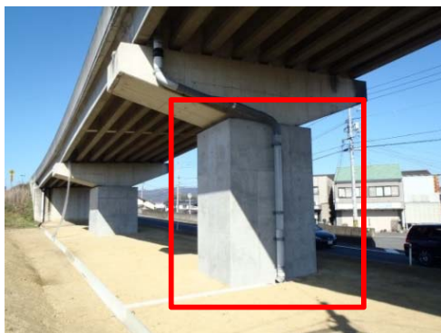
対策事例(橋脚の補強)
