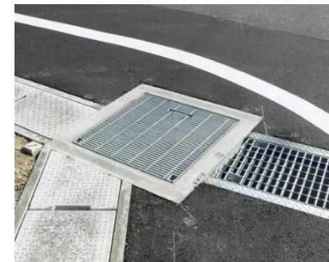
対策事例(排水施設の設置)
