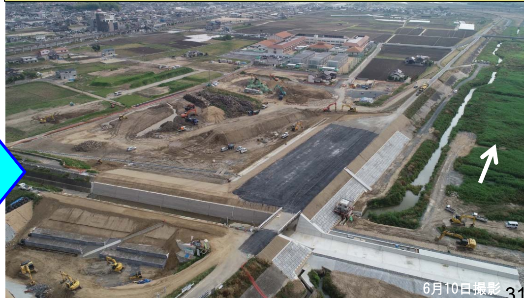
本堤防の復旧完了
