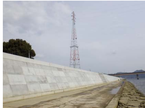
対策事例(高潮堤防整備)
