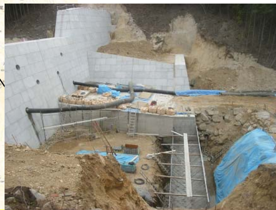
うえだみなみがわ ▲上田南川 コンクリート打設状況(垂直壁)
