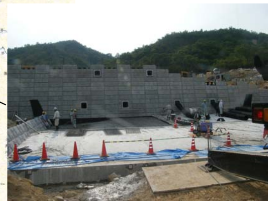
なみがわ ▲奈美川 ソイルセメント打設状況
