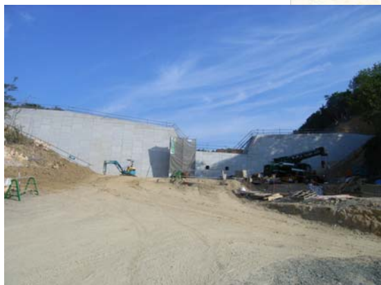
すがわ ▲素川 ソイルセメント打設完了
