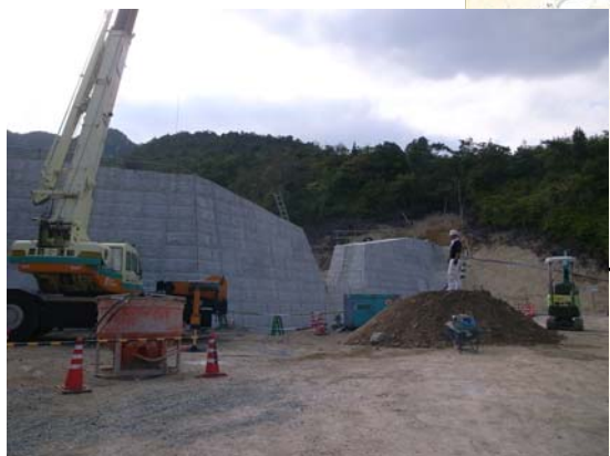
かみさとがわ ▲神里川 コンクリート打設完了
