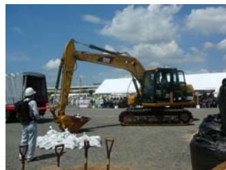
無人遠隔操作による工作機械ロボQを使用した土砂撤去作業
