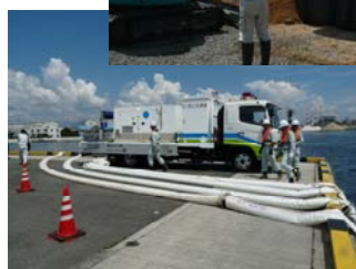
津波浸水の排除
