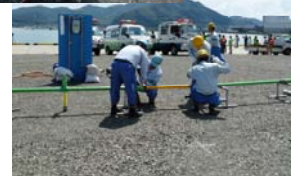
上水道等の復旧
