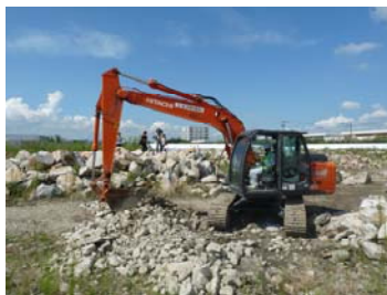
道路建設業協会、岡山県建設業協会による道路閉塞の障害物撤去作業
