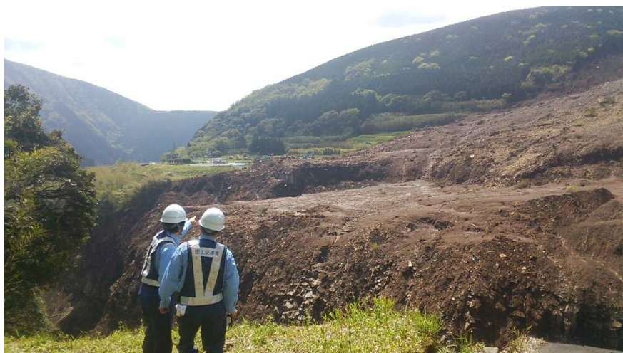
阿蘇大橋周辺 被災状況調査
