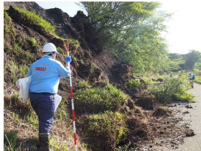
仙酔峡道路 被災状況調査
