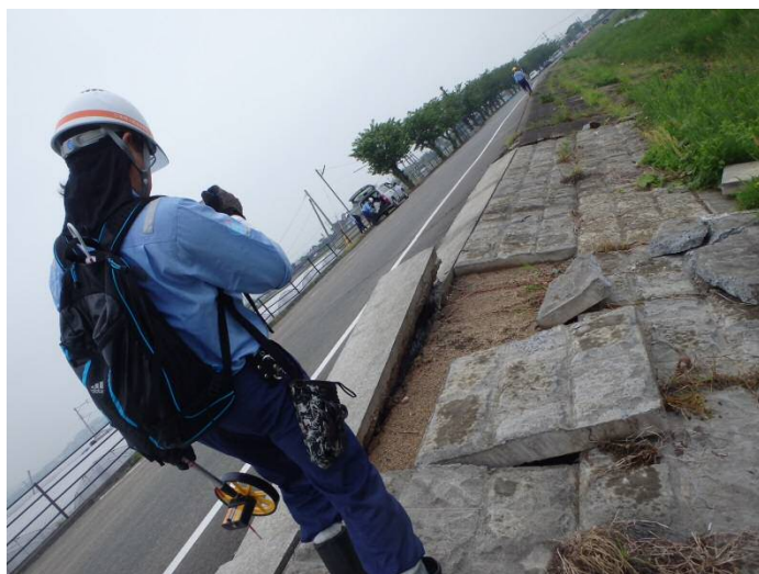
秋津川被災状況調査(益城町内)
