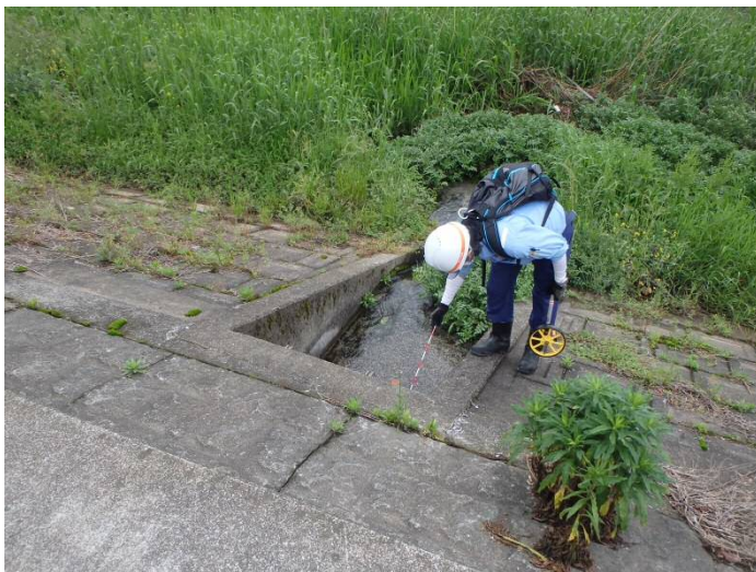
秋津川被災状況調査(益城町内)
