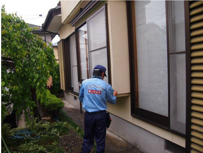
建築物判定班 熊本市内 調査状況
