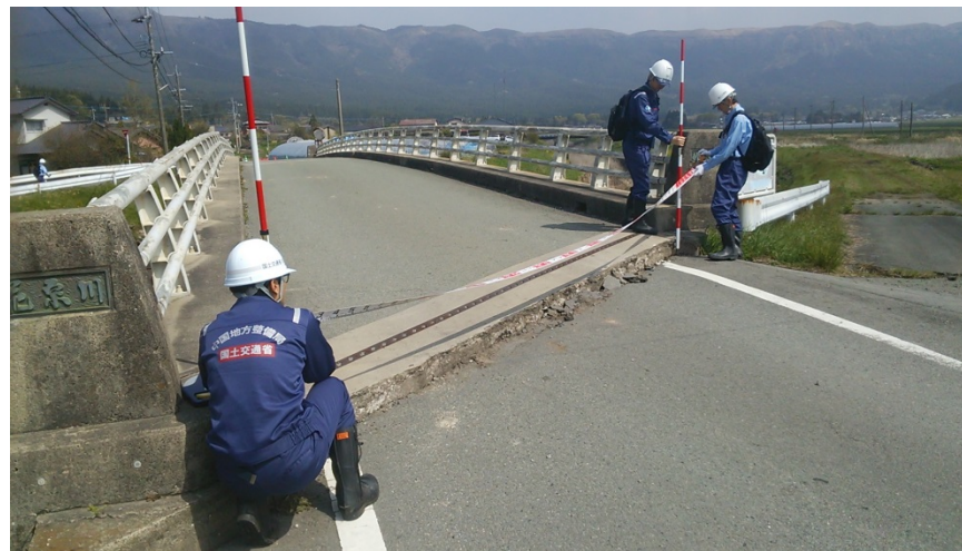
市道鍋釣線(新花原橋)被災状況調査
