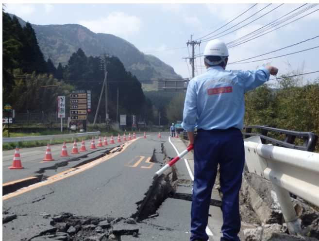
国道57号 被災状況調査
