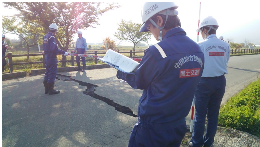
市道内牧中央線 被災状況調査
