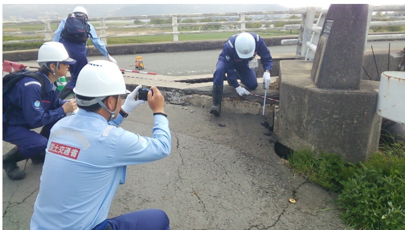
市道鍋釣線(新花原橋)被災状況調査
