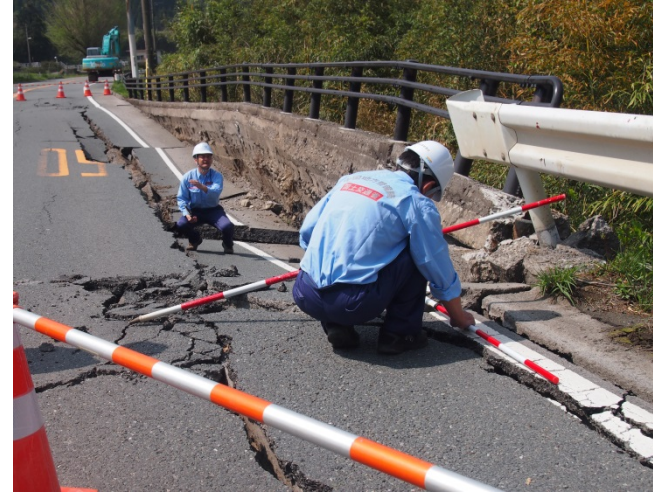
国道57号 被災状況調査
