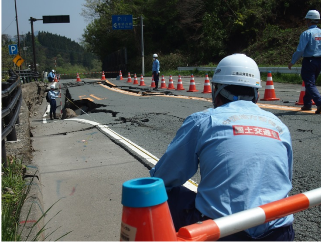
国道57号 被災状況調査
