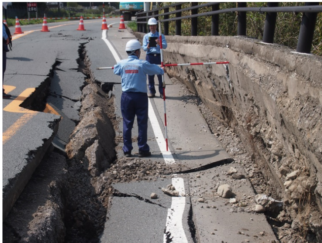
国道57号 被災状況調査
