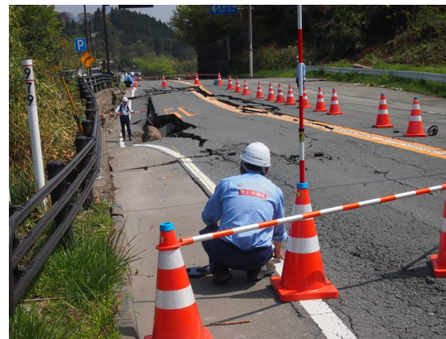
国道57号 被災状況調査
