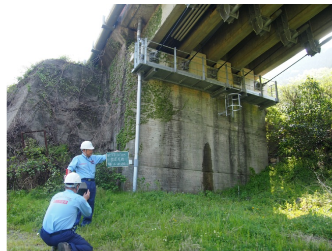
国道57号 被災状況調査
