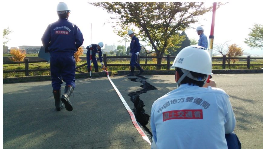
市道内牧中央線 被災状況調査
