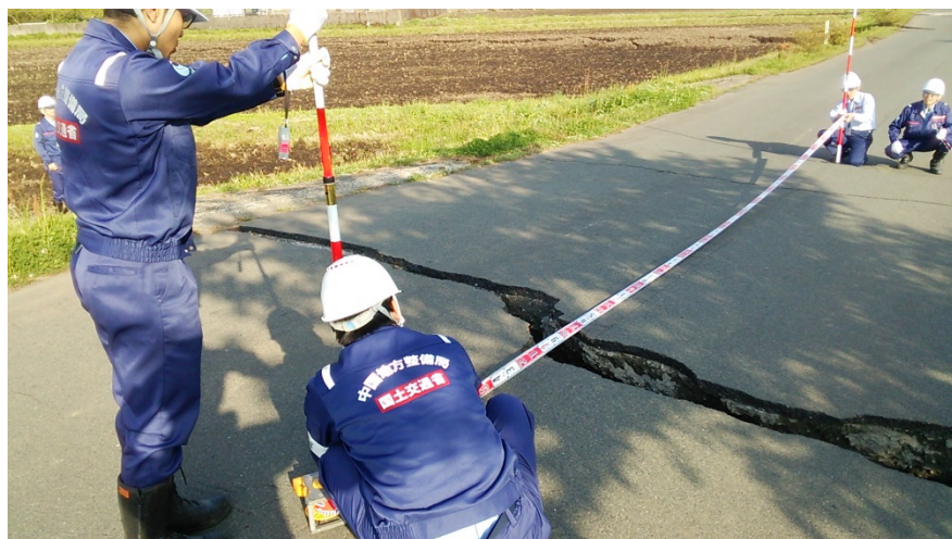
市道内牧中央線 被災状況調査
