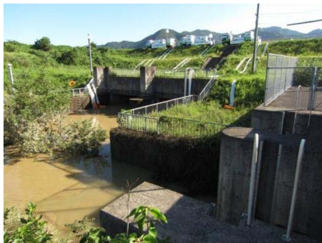
排水ポンプ作業完了(5:30)【応急対策班】
