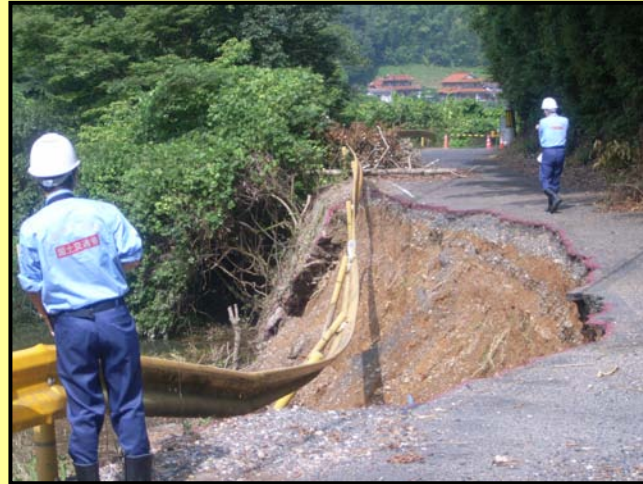
▲ 美祢地区調査状況(道路)
