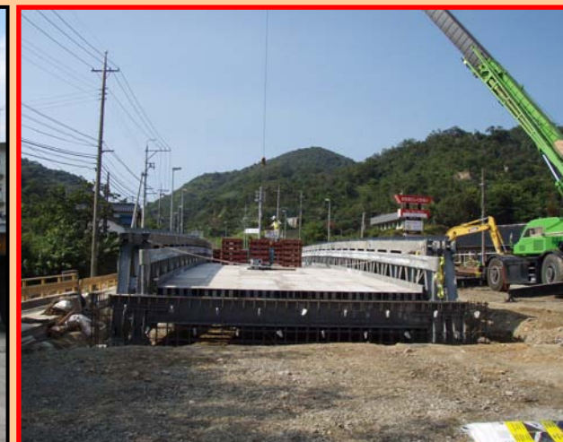
▲ 応急組立橋梁 架設完了 (一般国道262号)
