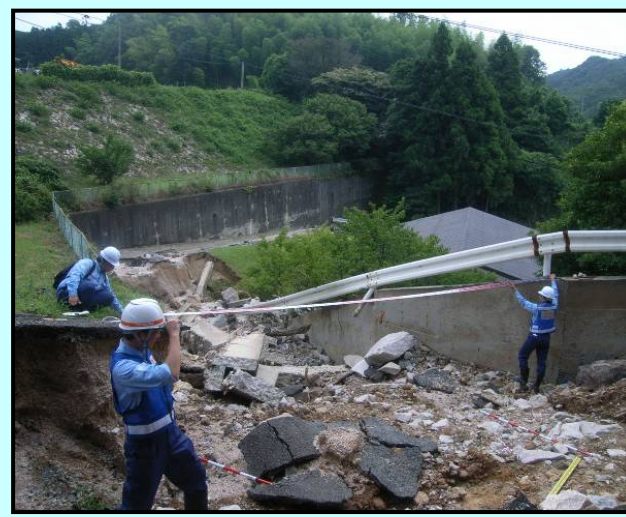
▲ 大道地区調査状況(道路)
