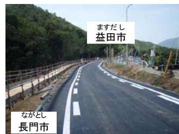
平成25年8月4日 15:00撮影 迂回路舗装工事等
