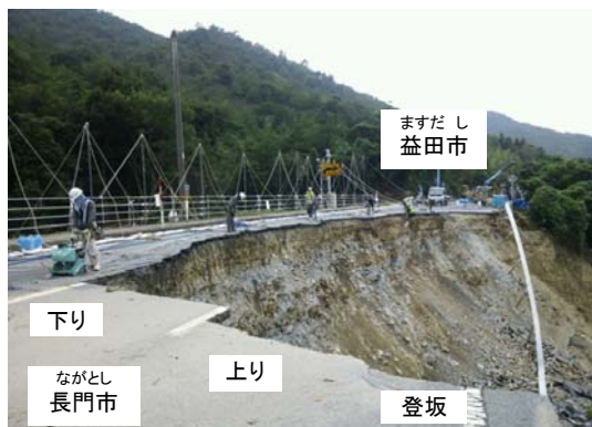
平成25年8月1日 14:00撮影 復旧作業状況
