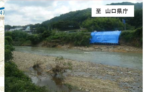
7/31 崩落部土のう及びブルーシート設置完了
