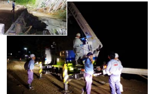
●照明車の派遣(夜間状況監視のため現場を照射) 【小瀬川水系瀬田川:山口県玖珂郡和木町瀬田】
