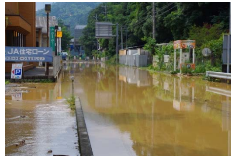
●国道2号路面冠水状況(14時時点) 【山口県岩国市上多田】
