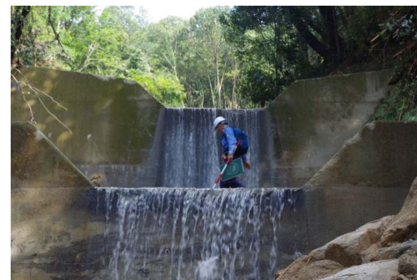
● 堰堤の堆砂状況確認
