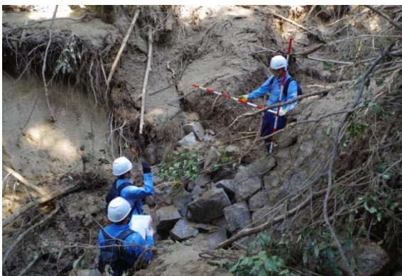
● 洗掘された溪流幅の計測作業
