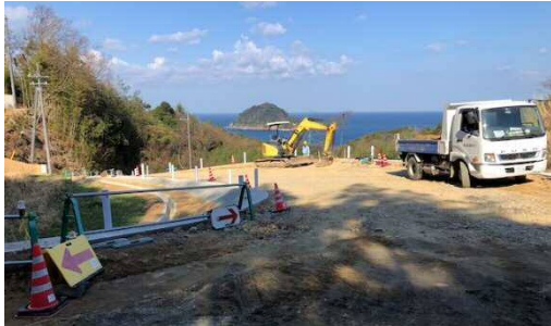
②宇田地区第1改良工事 (株)技工団 (町)寺ノ下青浦線の拡幅を行っています。
