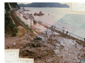
【写真②】S55被災状況
