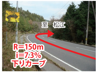
国道191号の急カーブと急勾配が複合した箇所
