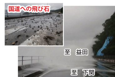
国道191号の越波状況
