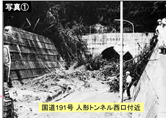
小浜地区被災状況(S58.7)
