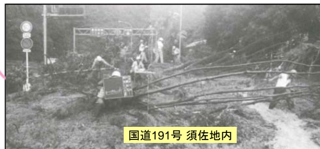
須佐地区被災状況(S58.7)
