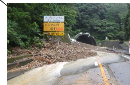
▲土砂崩れ発生箇所 (大刈トンネル東坑口)
