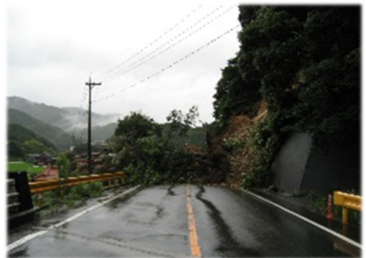
▲ 国道316号における被災状況(通行止め:4日間) (H22.7.14 長門市湯本四ノ瀬)
