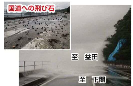
国道191号の越波状況
