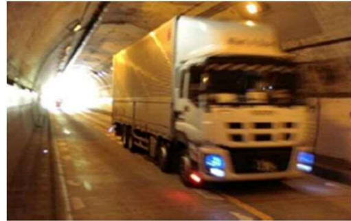
国道191号の幅員狭小トンネル （中央線をはみ出して走行する車両）
