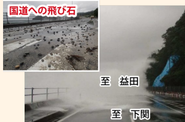
国道191号の越波状況
