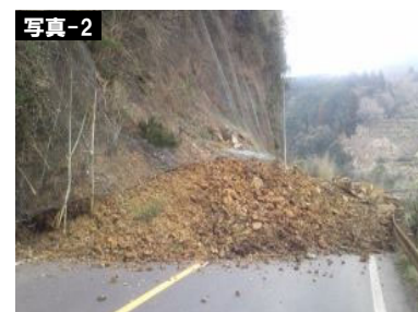
写真-2 ▲長門市俵山大羽山【H24.2 被災状況】
