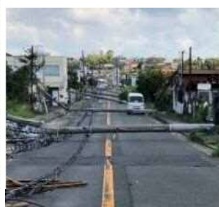
<電柱の倒壊による道路閉塞の事例>
