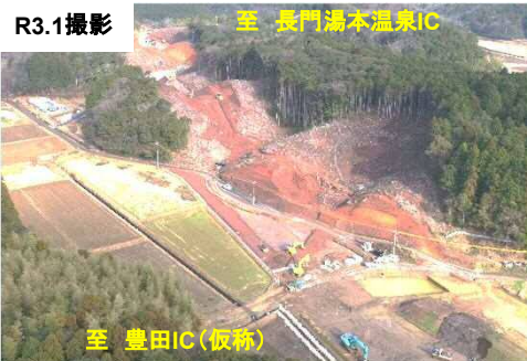
写真① 金道地区施工状況
