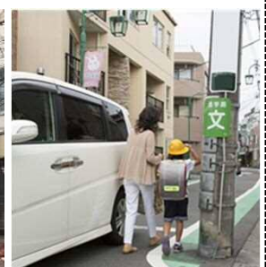
<歩行の支障となる電柱の事例>
