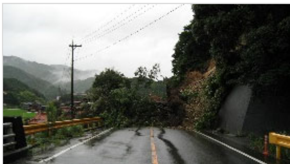
▲ 国道316号における被災状況(通行止め: 4日間) (H22.7.14 長門市湯本四ノ瀬)
