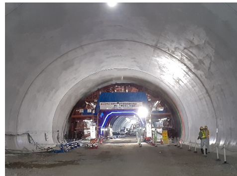
木与第3トンネルの施工状況
