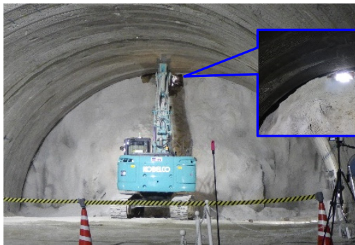
トンネル貫通時の状況
