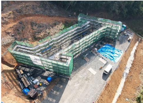
函渠工の鉄筋組立状況
