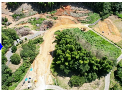
②【ボックスカルバート(鉄筋組立)】 長門市俵山地内 工事名：木津地区第3改良工事 (別紙-3参照)
