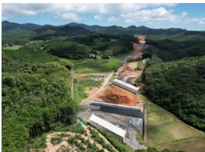
①【ICT土工(土質関係)】 下関市豊田町地内 工事名：金道地区第9改良工事 (別紙-2参照)
