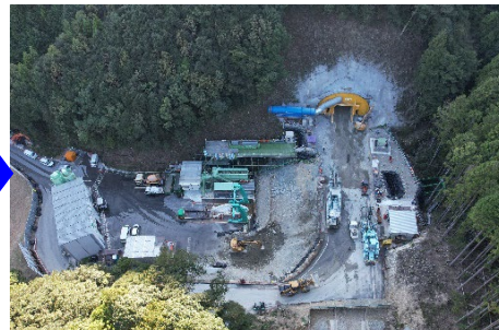
③【トンネル工事】 長門市俵山地内 工事名：第2トンネル工事 (別紙-4参照)
