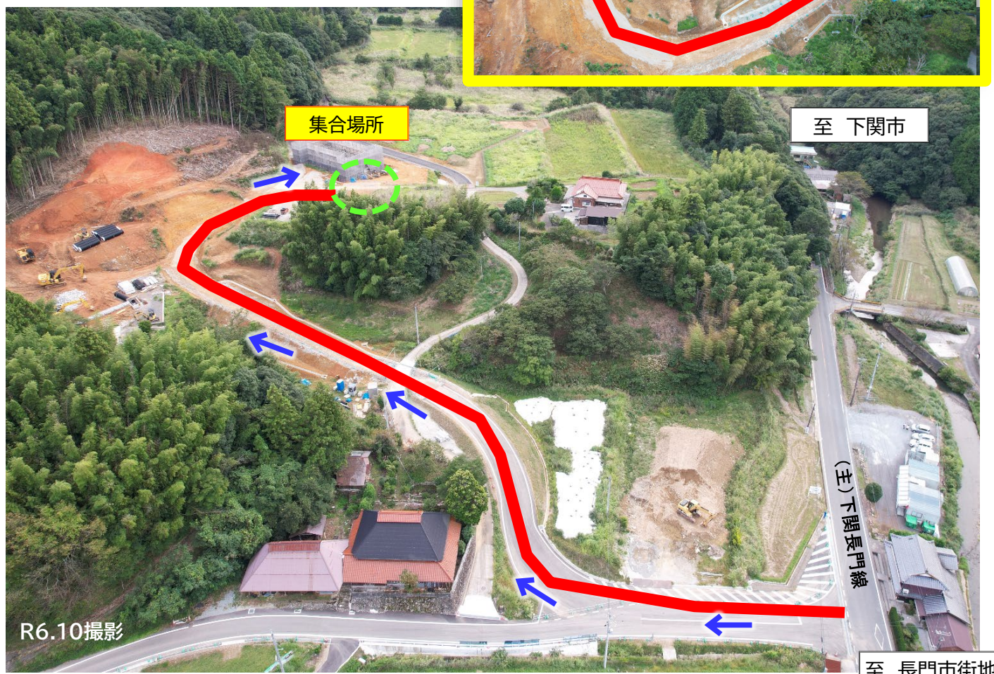
②見学箇所 木津地区第3改良工事
