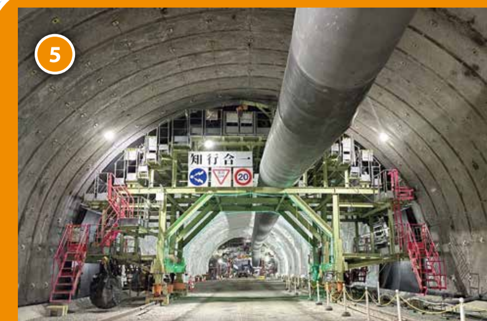
令和6年3月に俵山・豊田道路第1トンネル(仮称)が貫通し、現在は第2トンネル(仮称)を施工しています。
