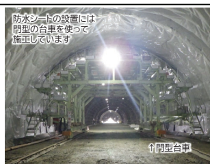
防水シートの施工状況
