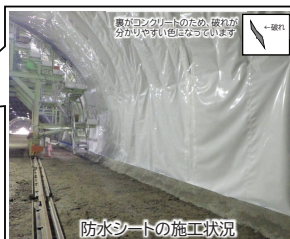
防水シートの施工状況
