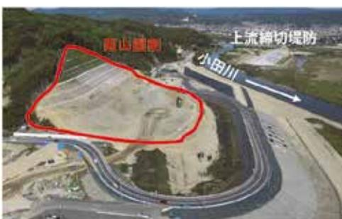
南山掘削工事は、山頂（標高76m）から約40m掘削が完了し、法面を安定させるためにアンカー工を施工しています。1月29日から硬い岩盤を掘削するため発破を開始しました。発破に伴い県道下原船穂線の通行規制を行っています。
