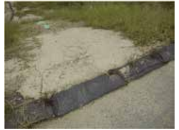
法面の侵食箇所補修後
