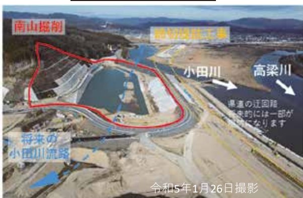
南山付近の進捗状況
