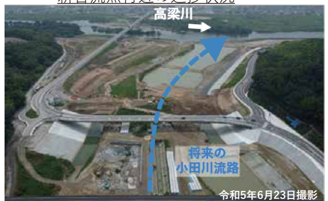
新合流点付近の進捗状況
