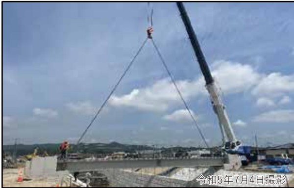
末政川 (ごぜ橋) 橋桁 架設状況
