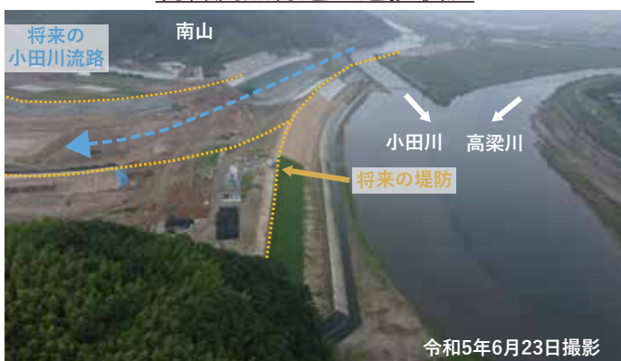
現合流点付近の進捗状況
