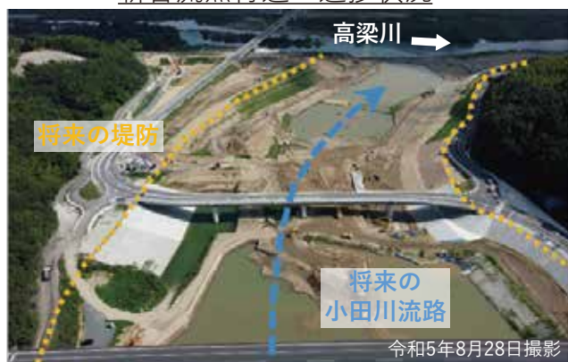
新合流点付近の進捗状況
