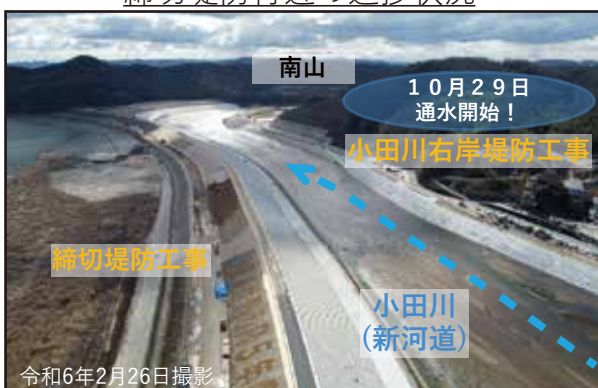
縮切堤防付近の進捗状況
