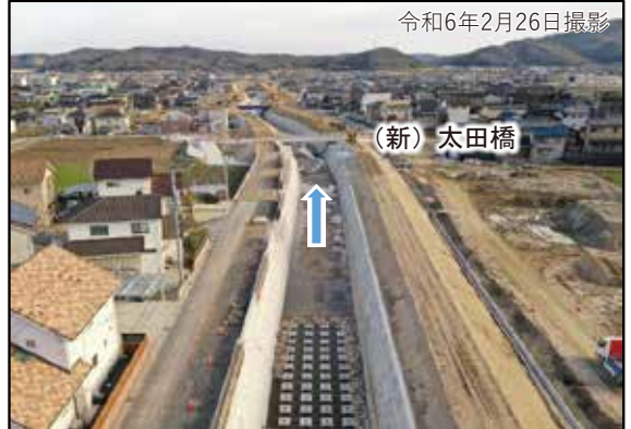
未政川 進捗状況 (太田橋周辺)
