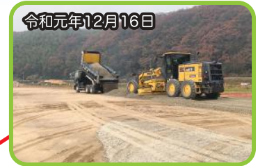
工事用道路を施工しています
