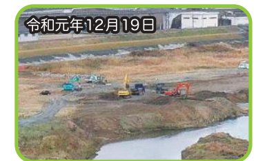
二万橋下流付近の掘削の様子
