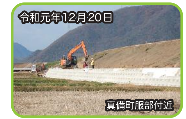
堤防の擁壁を施工しています
