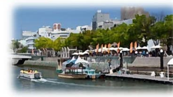
親水護岸の利用 (新町川/徳島市)
