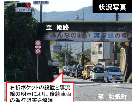
国道2号 伊部東交差点 (岡山県 備前市)
