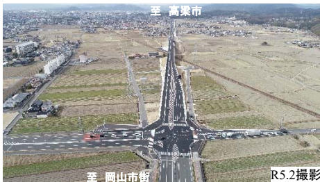
【写真①】天原地区の施工状況
