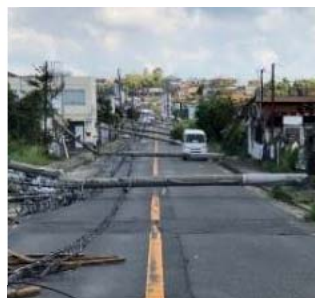
＜電柱の倒壊による道路閉塞の事例＞
