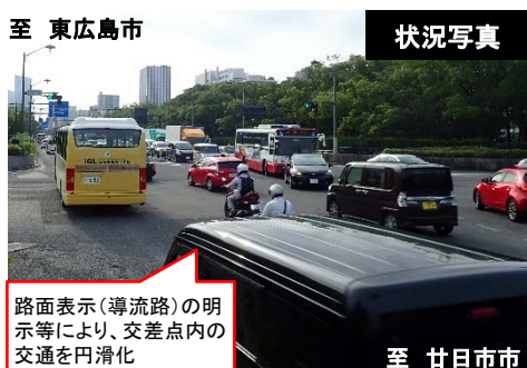
国道54号 広島城南交差点～ 県立総合体育館前交差点 (広島県 広島市)
