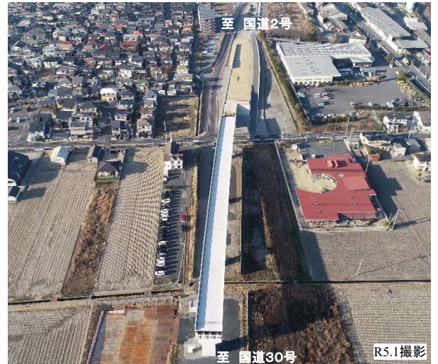
【写真①】大福地区の施工状況
