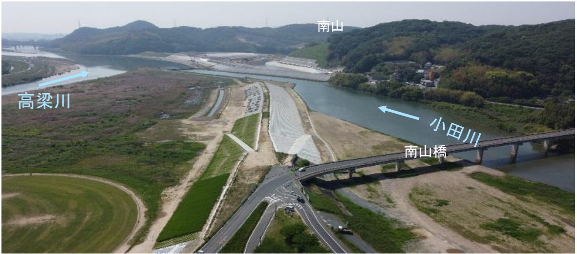
南山橋付近(締切堤防付近)
