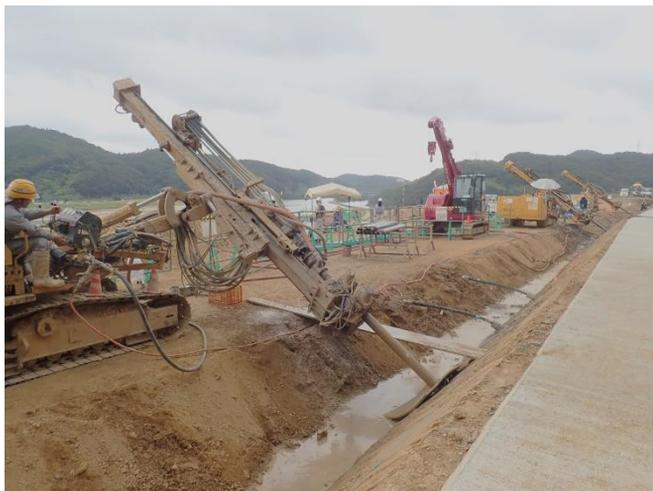
アンカーを用いて法面保護をしている様子
