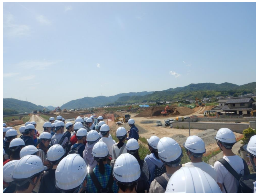
小田川の左岸3k400の災害復旧工事
