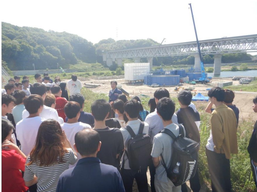
小田川合流点付替え事業の準備工事 (濁水処理施設)
