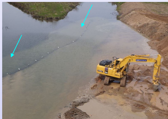
ネットで隔離した水域における河岸掘削 堤外水路除草時の水際植生の保全例 〔R4年8月10日〕
