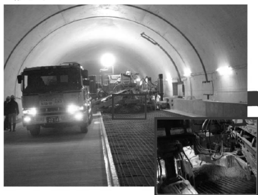
Co敷き均し(スプレッター)
