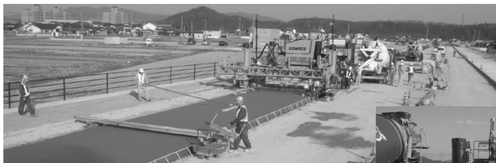
コンクリート舗装施工状況
