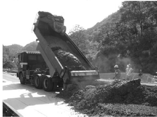
Co荷卸し(ダンプトラック運搬)
