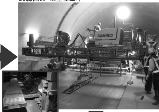
縦フロート仕上げ
