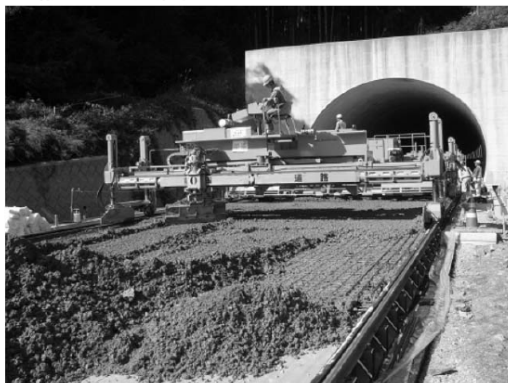
Coフィニッシャーによる締固め
