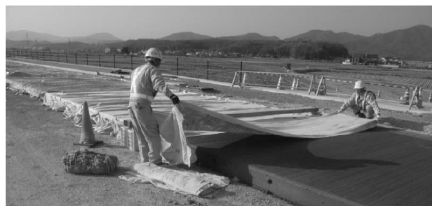
後期養生（シート養生）
