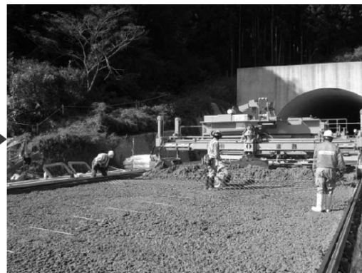
Co敷き均し(2層目)
