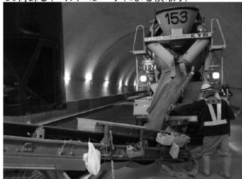
Co荷卸し(ベルトコンベアによる横取り)
