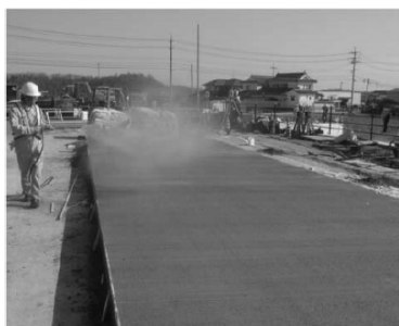
初期養生（塗膜養生）
