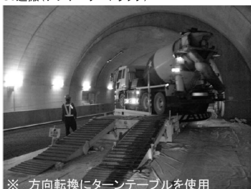
Co荷卸し(ベルトコンベアによる横取り)
