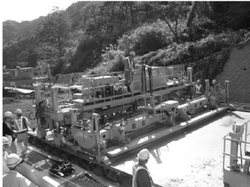
Coフィニッシャーによる締固め
