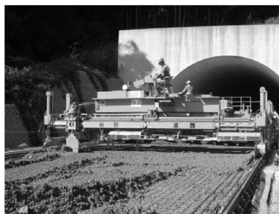
コンクリートスプレッダ(ブレード式)
