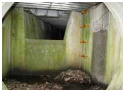
集水枡(直壁構造)
