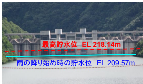
苦田ダム貯水位の状況
