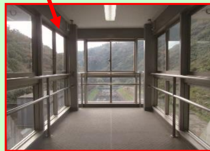
ダム堤体内見学施設(見学不可)
